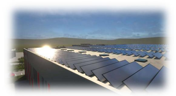
Il s'agit d'un système de panneaux photovoltaïques mis en œuvre en apposition sur un complexe d'étanchéité de toiture qui se compose de la façon suivante :
